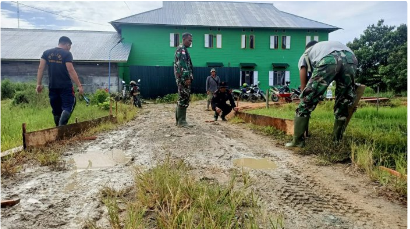
Cuaca Tak Menentu, Satgas TMMD Wiltas Ke-118 Kodim 0910/Malinau Kebut Pengerjaan Sasaran fisik
