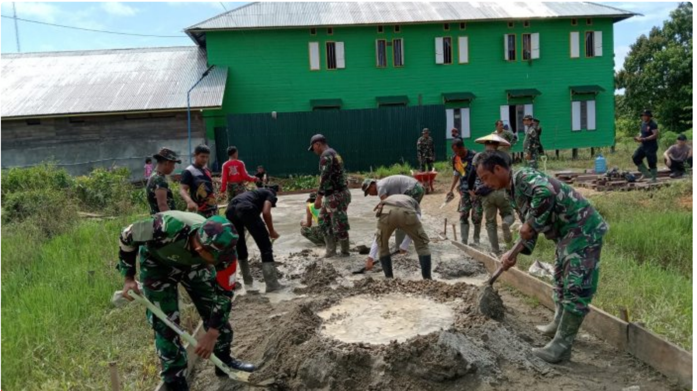
Dandim 0910/Malinau Letkol Alisun Terjun Langsung Bantu Satgas TMMD 118 dan Warga Semenisi Jalan
