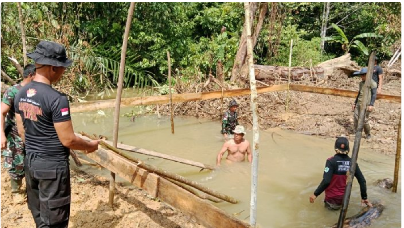
Jebur ke Sungai, Satgas TMMD ke 118 Kodim 0910/Malinau Pasang Papan Mal Jembatan
