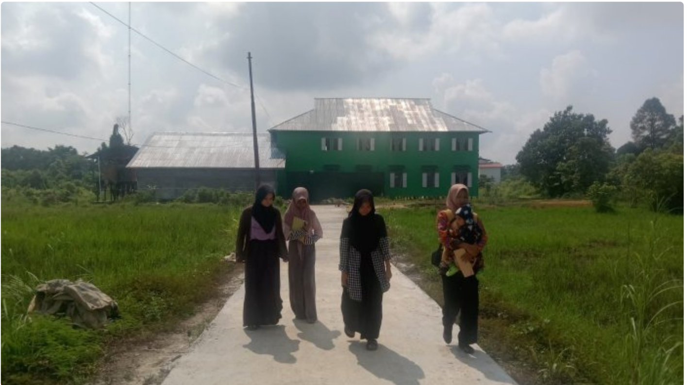
Santriwati dan Warga Sudah Dapat Menikmati Jalan Hasil TMMD Ke-118 Wiltas Kodim 0910/Malinau
