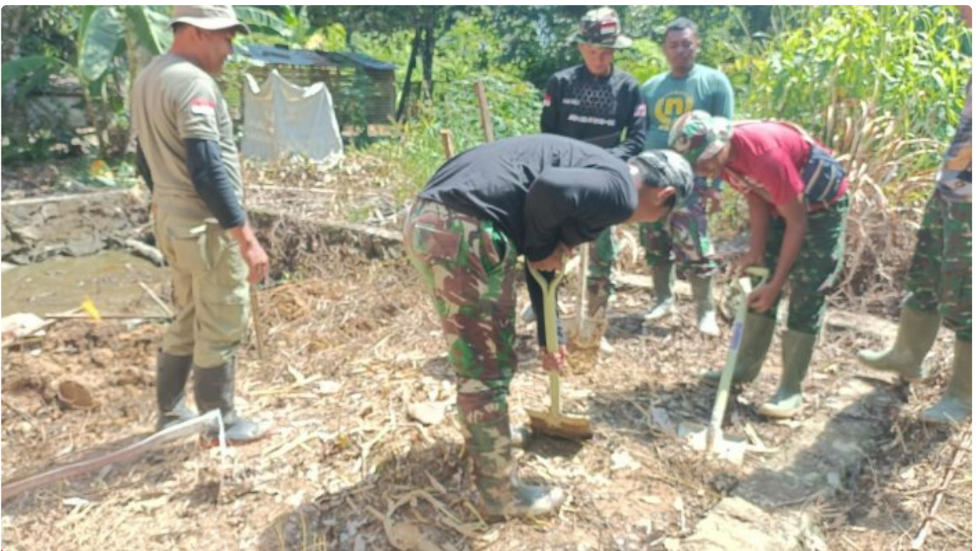
Sasaran Tambahan TMMD Ke-118 Wiltas Kodim 0910/Malinau Mulai di Kerjakan
