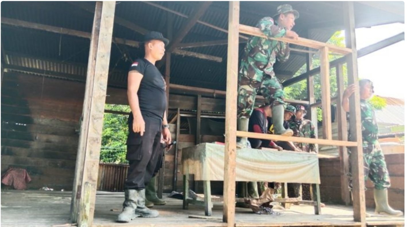
Terkejut Dan Syukur Utkapan Bapak Charles Rumahnya Di Rehab Satgas TMMD Ke-118
